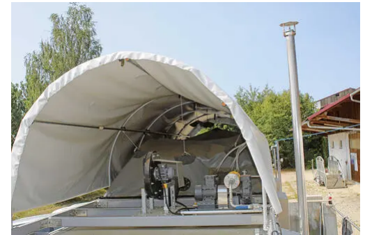
© Helmut Süß Biogasanlage mit Trockenfermenter: Das Biogas wird in frei hängenden Säcken gesammelt.
